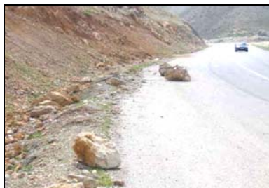
شکل ۴- ریزش ایجاد شده در اثر زلزله در مسیر جاده بروجرد به خرم آباد
